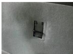
3、フック内側のツメをマイナスドライバー等で押さえながら外します。
