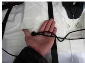
7、もう片方のヒモを、その輪の中を通し結び固定します。
